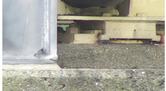
水管橋台座部分
