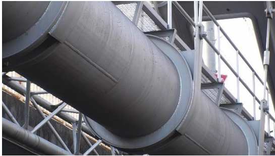
ドローンからの撮影・記録した水管橋
